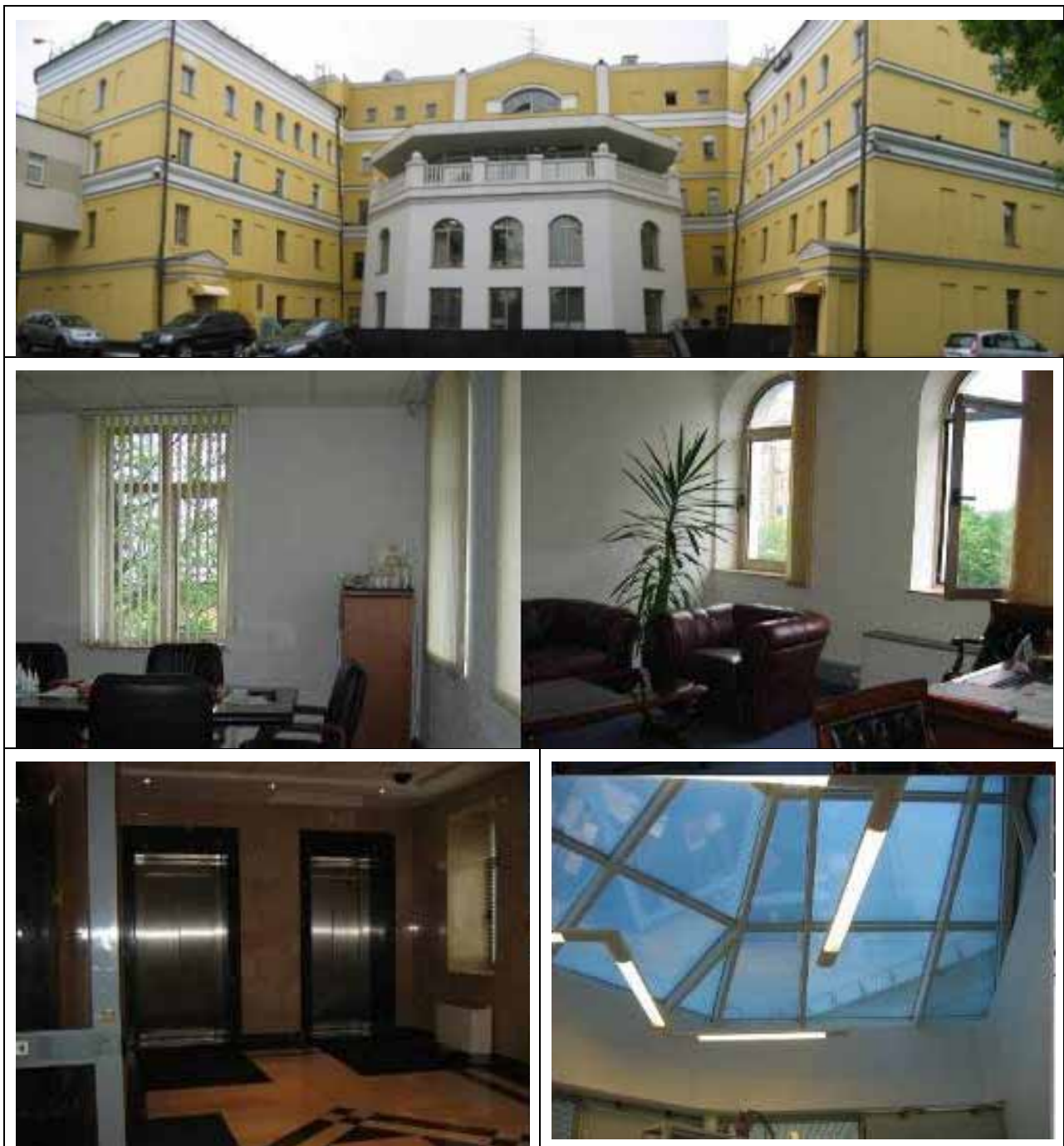
Рис. 15.2 Внешний вид здания ул. Погодинская, д.24, стр.1
