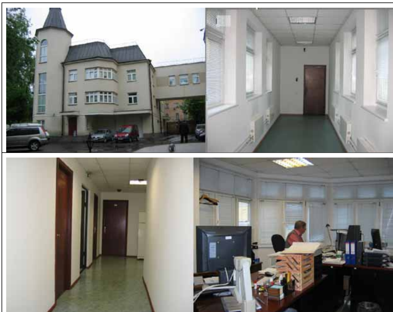
Рис. 15.3 Внешний вид здания ул. Погодинская, д.24, стр.2
